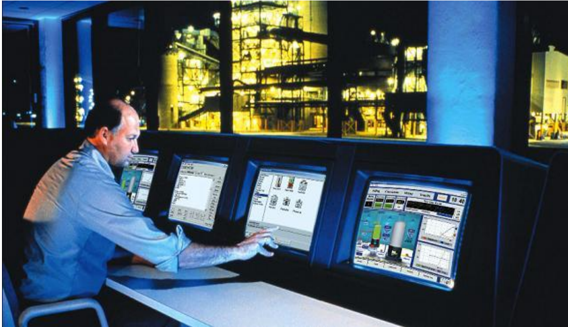
Figura 1: Operador de SCADA interactuando con la interfaz hombre-máquina (HMI). (kersel, 2008)
