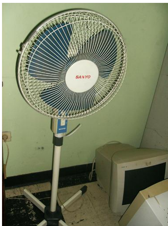
Figura 24: Equipo para la climatización del local de los servidores.
