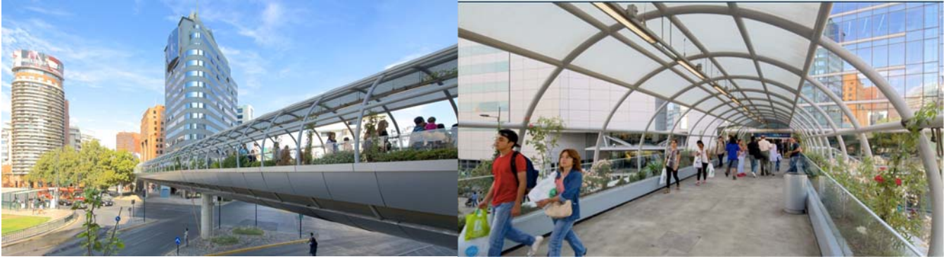
Figura 1: Pasarela Mall Costanera Center Fuente: Expedia.com.sg
